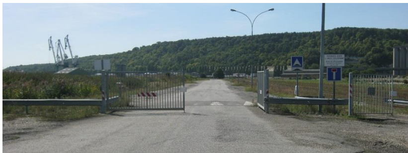
Photographie 16 : Accès routier actuel au QPC
