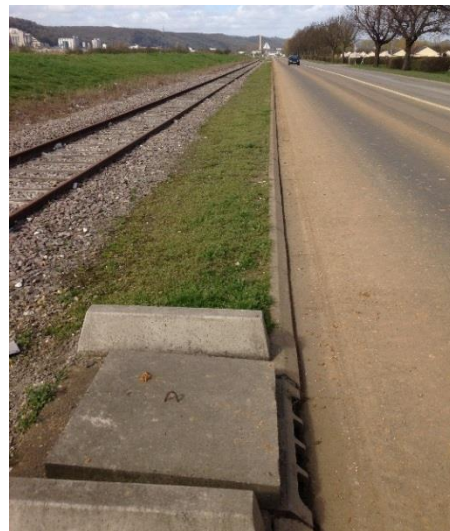
Photographie 1 : Assainissement pluvial du Boulevard Maritime à hauteur du QPC
