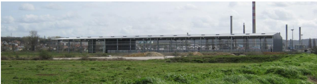
Photographie 11 : Travaux d'implantation du site industriel SURVEYFERT
