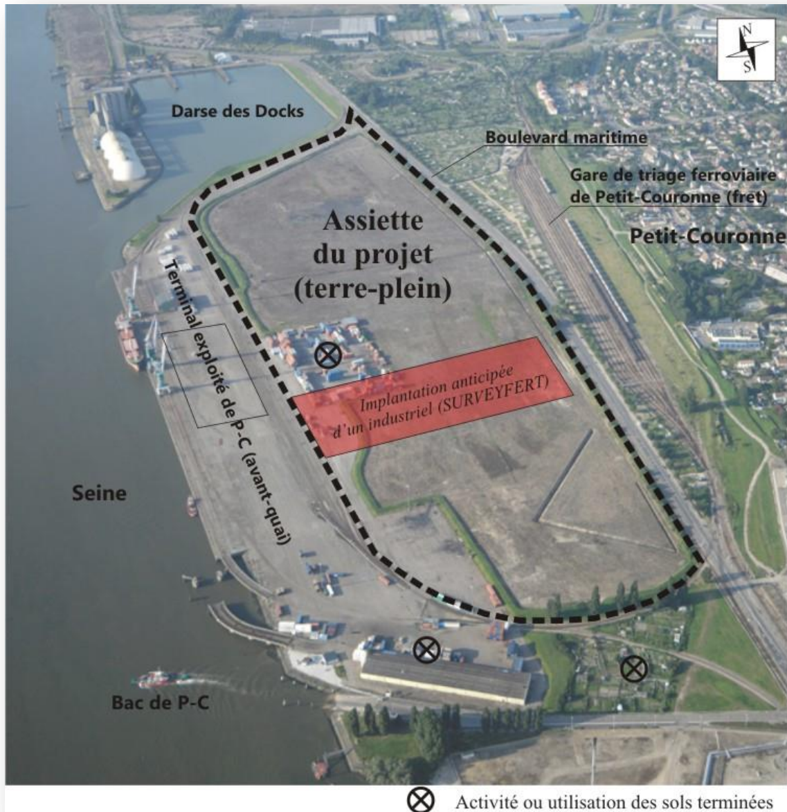
Figure 5 : Vue aérienne de la zone du projet
